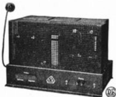
Für ganz große Plätze ist die Körting-Endstufe 18 Watt das geeignete Gerät. — Zur Verstärkung von Radio-Empfang kann dieser Endstufe jeder völlig brumme-freie unverzerrt arbeitende Empfänger vorgeschaltet werden, der eine RE 134, 304 oder 604 in der Endstufe hat. Bei Empfängern mit Schutzgitter-Endröhren (RES 164, RENS 1374d usw.) sind besondere Koppelungen notwendig, um Verzerrungen zu vermeiden.
